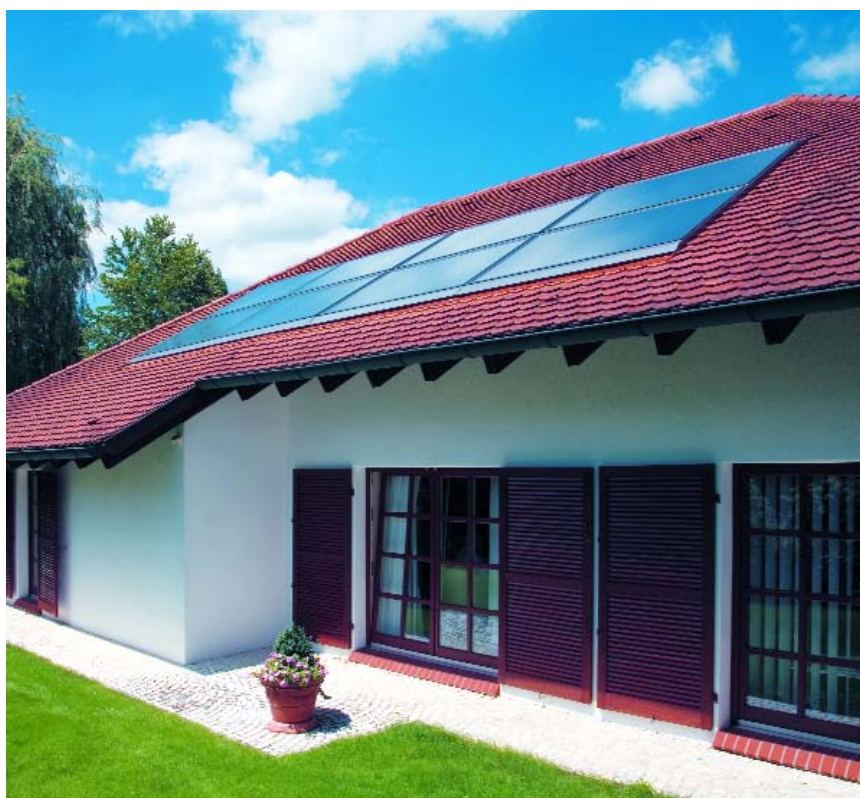
Perfekt takinstallation av Weishaupt solfångarkollektorer (System Takinfällt)
