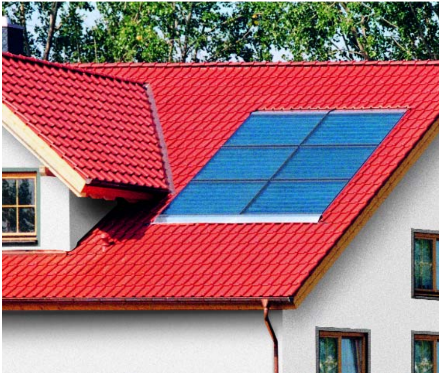
Perfekt takinstallation av Weishaupt solfångarkollektorer (System Takinfällt)
